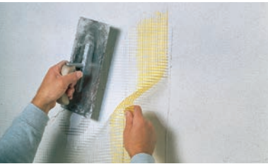
ベースコートと補強メッシュの施工
