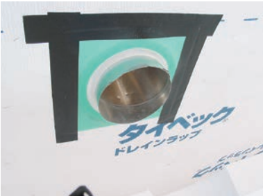
透湿防水シート及びサッシ・設備取合の確認
