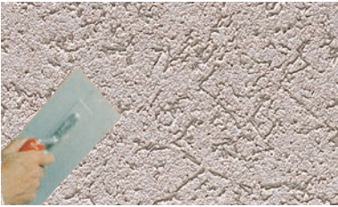
トップコートの施工
