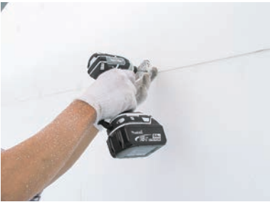
EPS断熱材とワッシャーの施工
