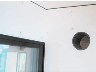
軒天・サッシ及び設備との取合
