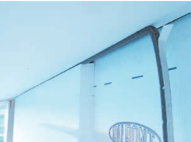
シーリングテープの施工
