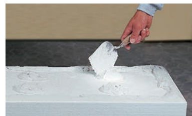
接着材：Sto-ADH-B 断熱材：Sto EPSボード
