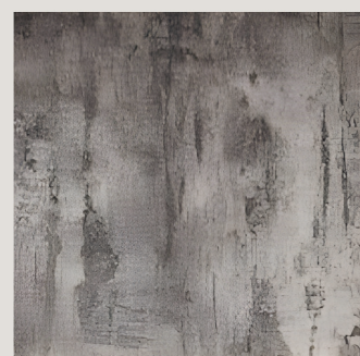
2回目をランダムに行った あとに、コテで押さえ、最 後に蜜蝋waxでエイジン グ。
