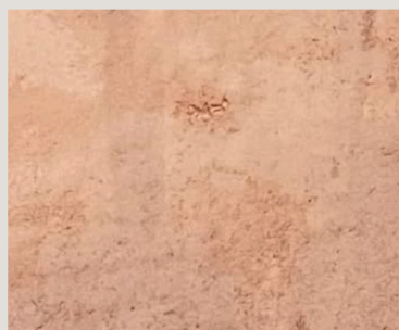
骨材の大きさを活かし、あえて巣穴を埋めずに、押さえる。
