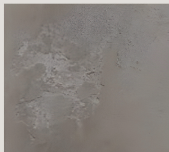
2回目は全体に塗布せず、トラバーチン風にし、押さえる。
