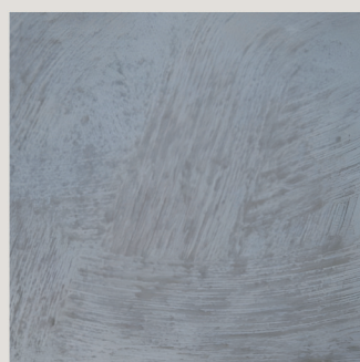
2回目に刷毛引きをし、そ の後にヘッドカットをする ように押さえ込む。凸の部 分のみコテを当てます。
