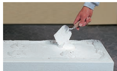
接着材：Sto-ADH-B 断熱材：Sto EPSボード
