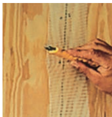
ジョイント補強メッシュ: Sto Guard Mesh
