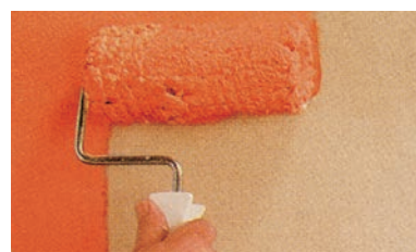
オーバーコートによるメンテナンス
