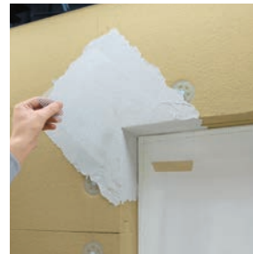
コーナーアングルメッシュの施工 (サッシがダキ納まりの場合)
